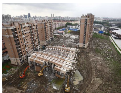
(a) 建筑物倒塌
