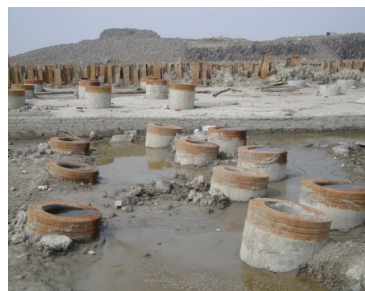
(a) PHC 管桩桩头偏移
